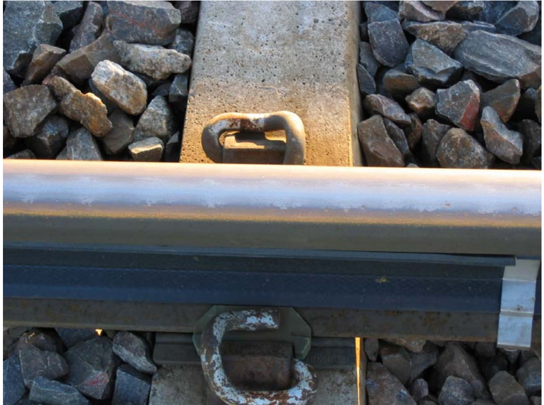
Kuva 21. Korrugaatiota kiskon kulutuspinnoissa.
